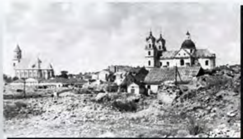
Разрушения в г. Броун.
