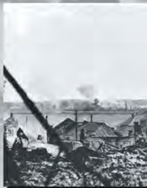
Разрушения в Ивоньке.
